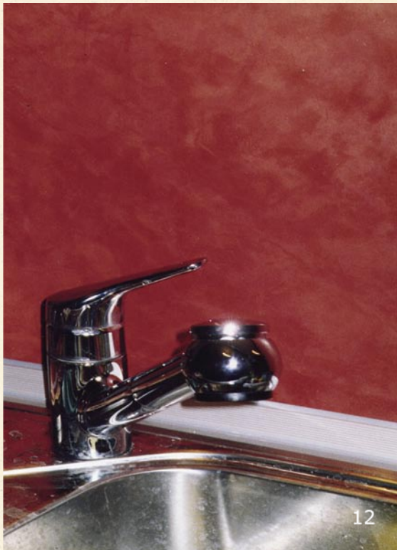
Spritzschutz aus Tadelakt leuchtend rot eingefärbt.
