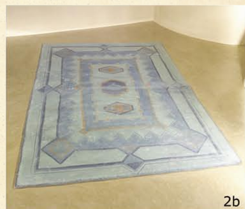
Teppich mit Stolperkante in den frischen Tadelakt gemalt und mit Wasserglas fixiert
