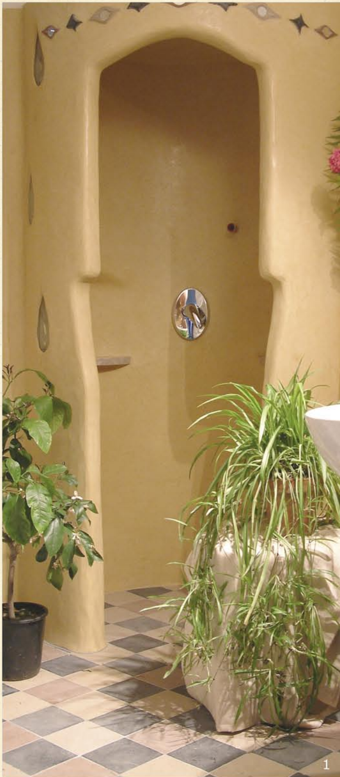
Teppich mit Stolperkante in den frischen Tadelakt gemalt und mit Wasserglas fixiert
