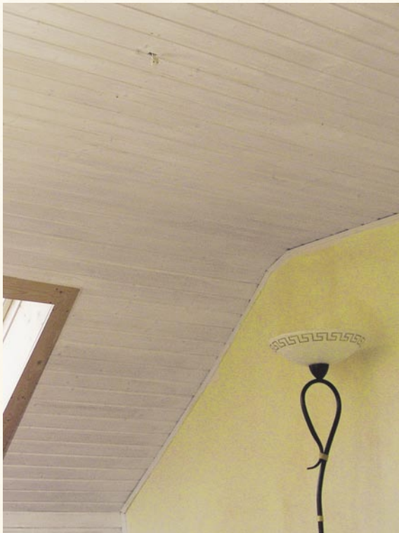
dunkel gewordene unbehandelte Profilbretter werden mit weißer GekkoSOL Lasur wieder hell
