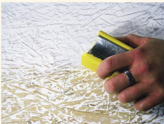
„Kalken“ von Holz und Holzwerkstoffen, hier OSB Platte. Arbeitsschritte: 1. Ausbürsten in Faserrichtung (bei OSB nicht notwendig) 2. Kasein Volltonfarbe weiß aufstreichen und mit Kunststoff- Glättspachtel abziehen 3. Schleifen und entstauben 4. Ölen oder Wachsen, hier Saffor Lappenwachs
