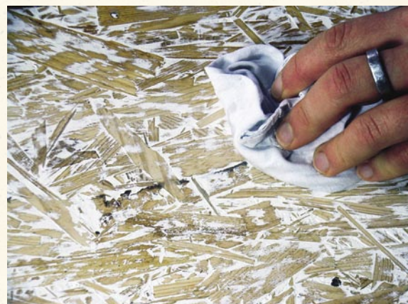
„Kalken“ von Holz und Holzwerkstoffen, hier OSB Platte. Arbeitsschritte: 1. Ausbürsten in Faserrichtung (bei OSB nicht notwendig) 2. Kasein Volltonfarbe weiß aufstreichen und mit Kunststoff- Glättspachtel abziehen 3. Schleifen und entstauben 4. Ölen oder Wachsen, hier Saffor Lappenwachs
