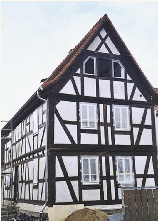
Fachwerk in Standölfarbe, Fa. Pueblo Lehmbau, 56479 Waldmühlen
